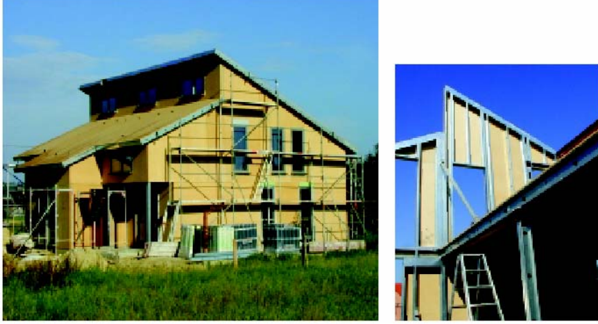
Resim 12 hafif çelik sistemlerde boşluk oranları yığma yapı ilkelerine benzer şekilde kısıtlıdır.
