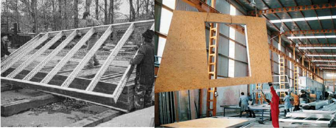
Resim 10 hafif çelik sistemlerde ızgara pano ve yüzeyi kaplanarak bitmiş yüzeysel pano
