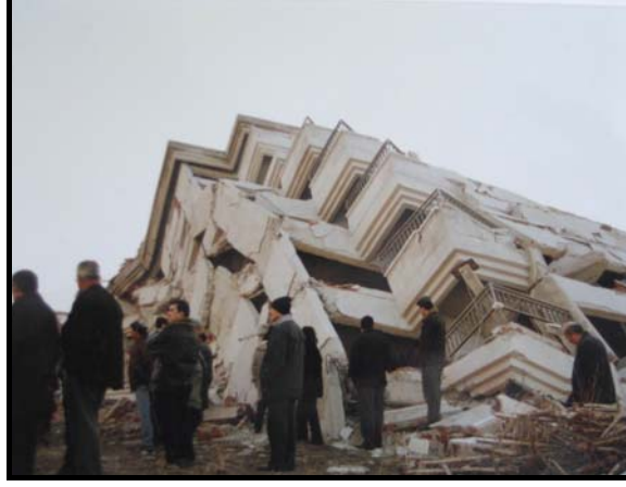
Şekil 5. Deprem etkisi karşısında tamamen yıkılan ve konut olarak kullanılması tasarlanan betonarme karkas yapı görünüşü.
