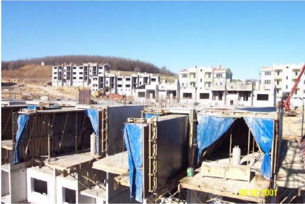
Yarım tünel kalıbın çıkarma iskelesi üzerine sürülmesi
