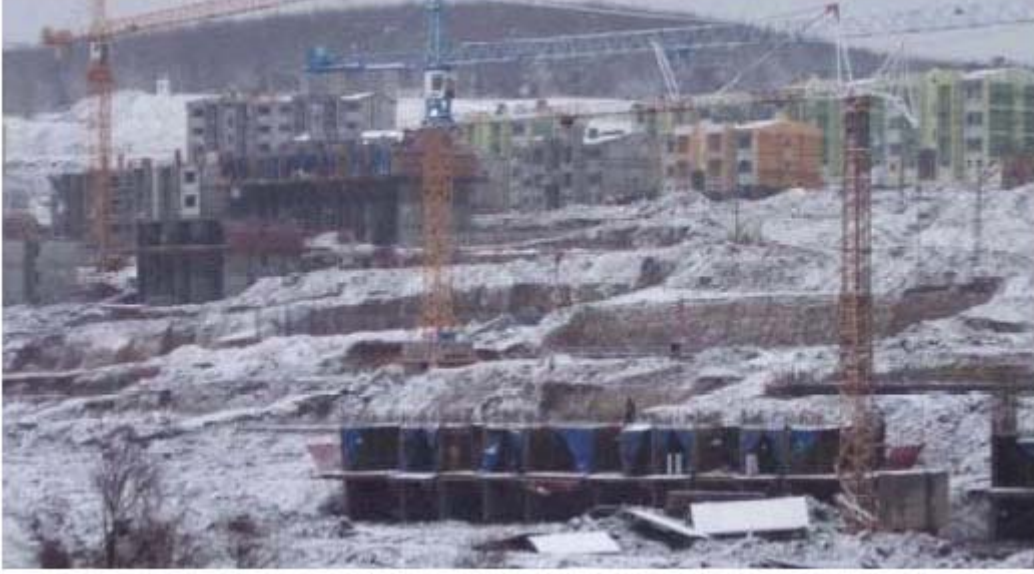
Tünel Kalıp (Adapazarı-Camili köyü mevki)
