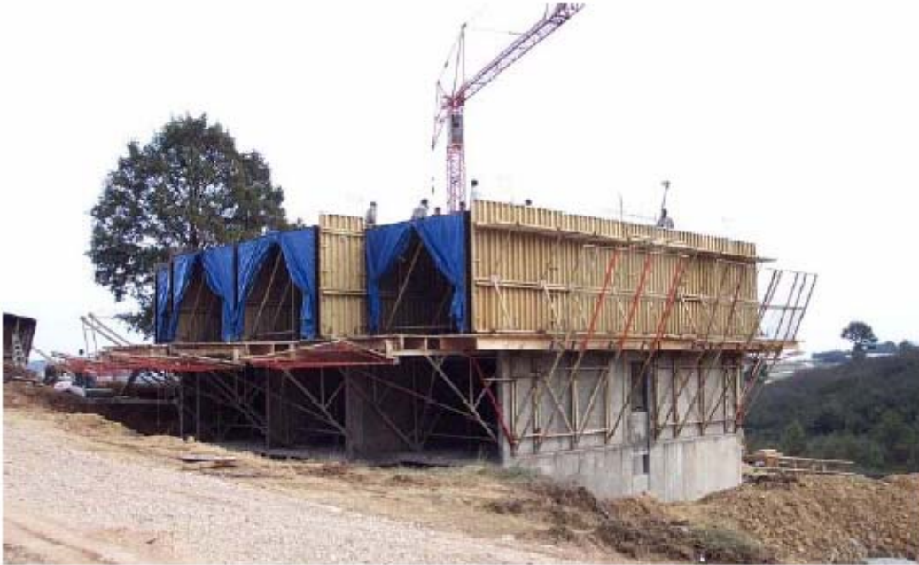
Tünel Kalıp Örneği
