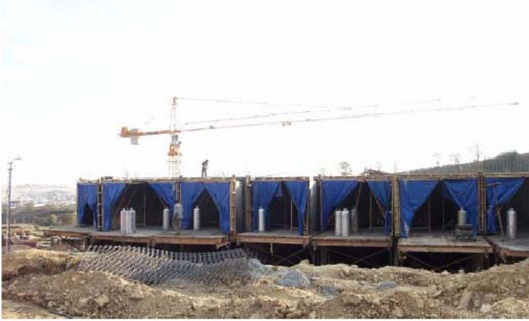
Tünel Kalıpta Isıtma Sobaları İle Kürleme
