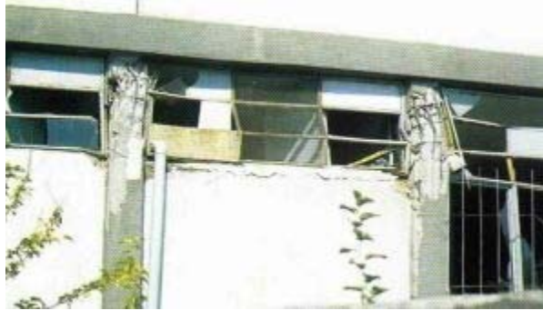
Şekil-14. Düzce Lisesi- Kısa kolon etkisine bağlı olarak kolonlarda ortaya çıkan hasarlar (Çelik, Çili, Özgen, 2000)
