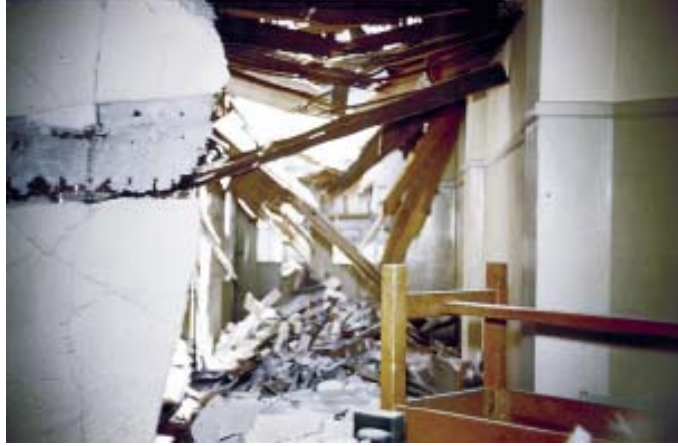
Şekil-20. Deprem sonrasında kaçış yollarının kopan malzeme parçaları ve tefriş elemanları ile geçilemez duruma gelmesi, Bakersfield, Kern County, CA, 1952 (FEMA 424 – Kaynak: National Information Service For Earthquake Engineering, University of California, Berkeley)
