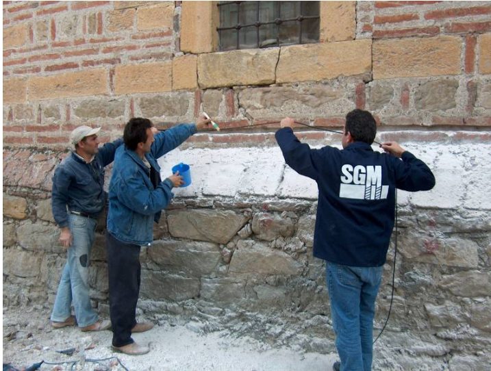
Şekil-3. Abide Hatun Cami'nin FRP çubuklarla güçlendirme uygulaması Kaynak: Bayraktar, 2006.
