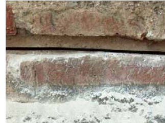
Şekil-3. Abide Hatun Cami'nin FRP çubuklarla güçlendirme uygulaması Kaynak: Bayraktar, 2006.
